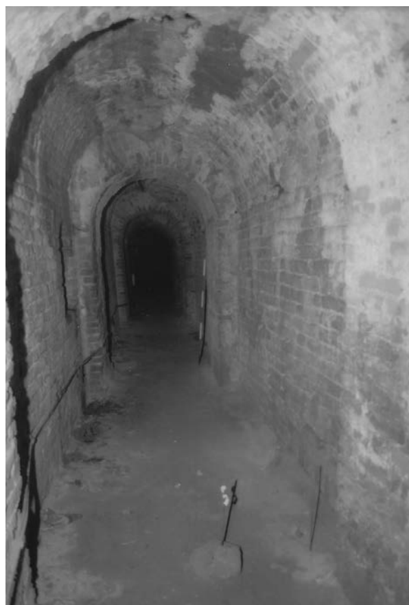
Figura 2 Uno scorcio del cunicolo principale della Strada Coperta.
